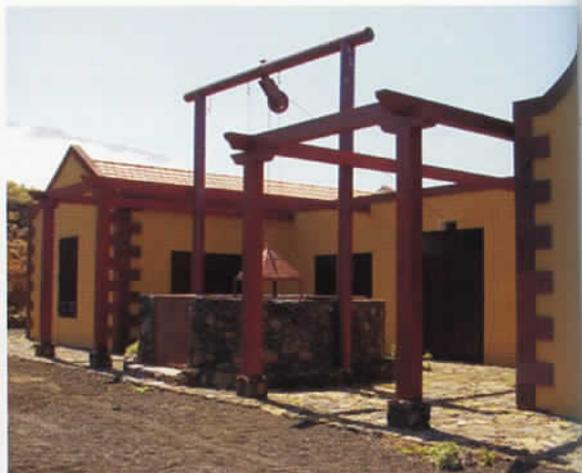
Depósito de regulación y estación de bombeo de "Los Roquillos" (El Hierro), mimetizados bajo la forma de una casa herreña. Esta red de transporte eleva 50 l/s a 750 metros de altura mediante tres impulsiones, y con ello se consigue el abasto urbano a toda la isla de El Hierro. El pozo que se observa en primer término permite la salida de la tubería que salva el acantilado del valle de El Golfo.
